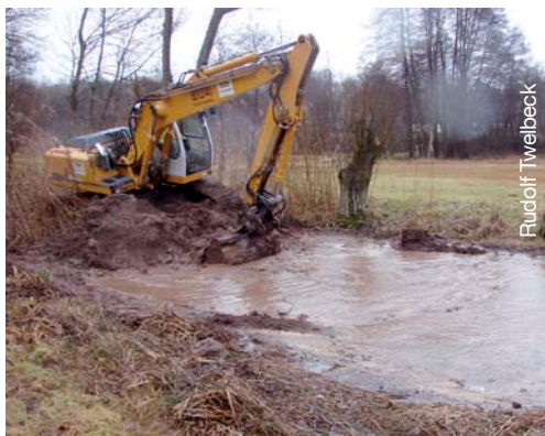
Aushubarbeiten am Mühlgraben
