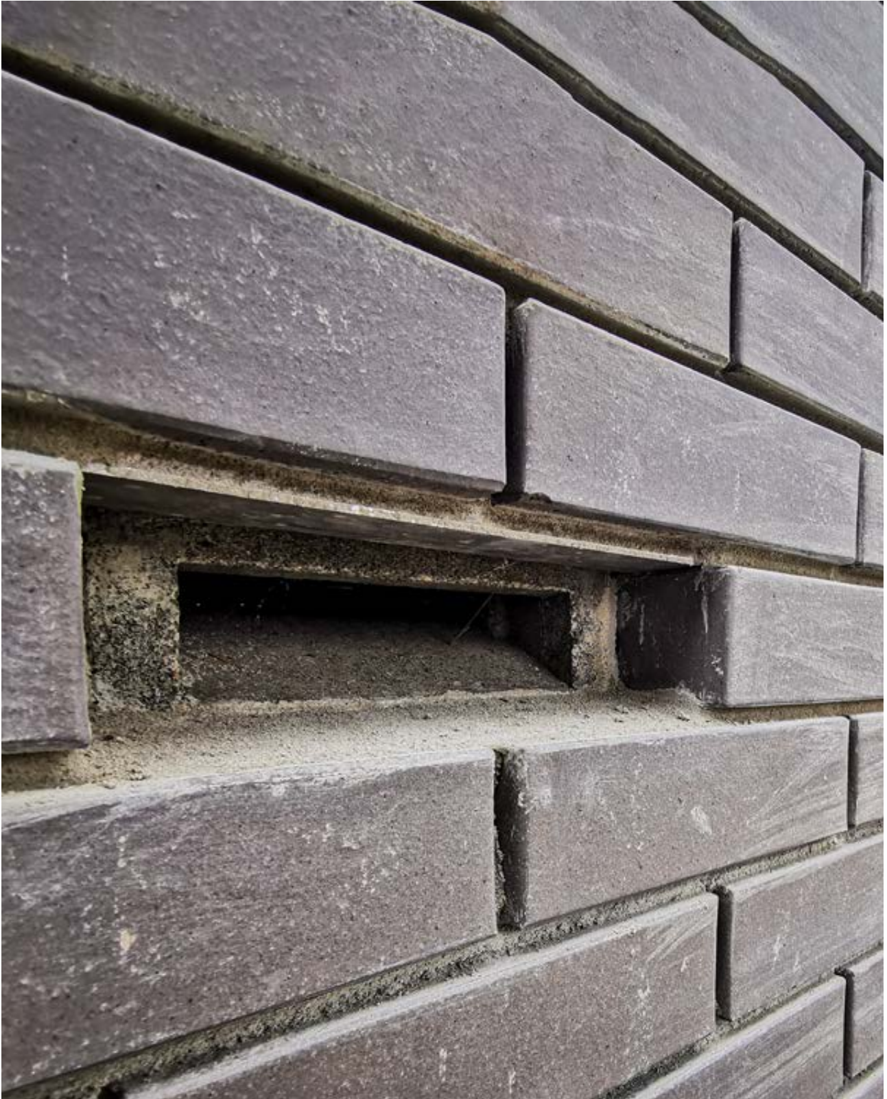
Nach Sanierung in Fassade eingelassene Fledermausquartiere
