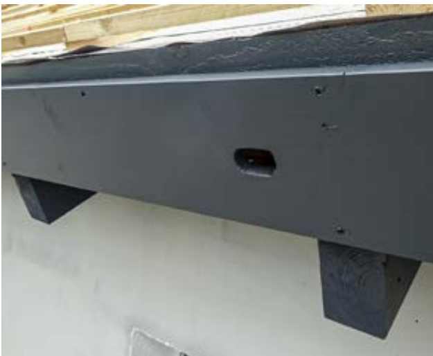
Neu geschaffener Nistplatz für Mauersegler und Haussperling in der Traufe. Das Einflugloch befindet sich im Stirnbrett, der Brutraum liegt geschützt dahinter.
