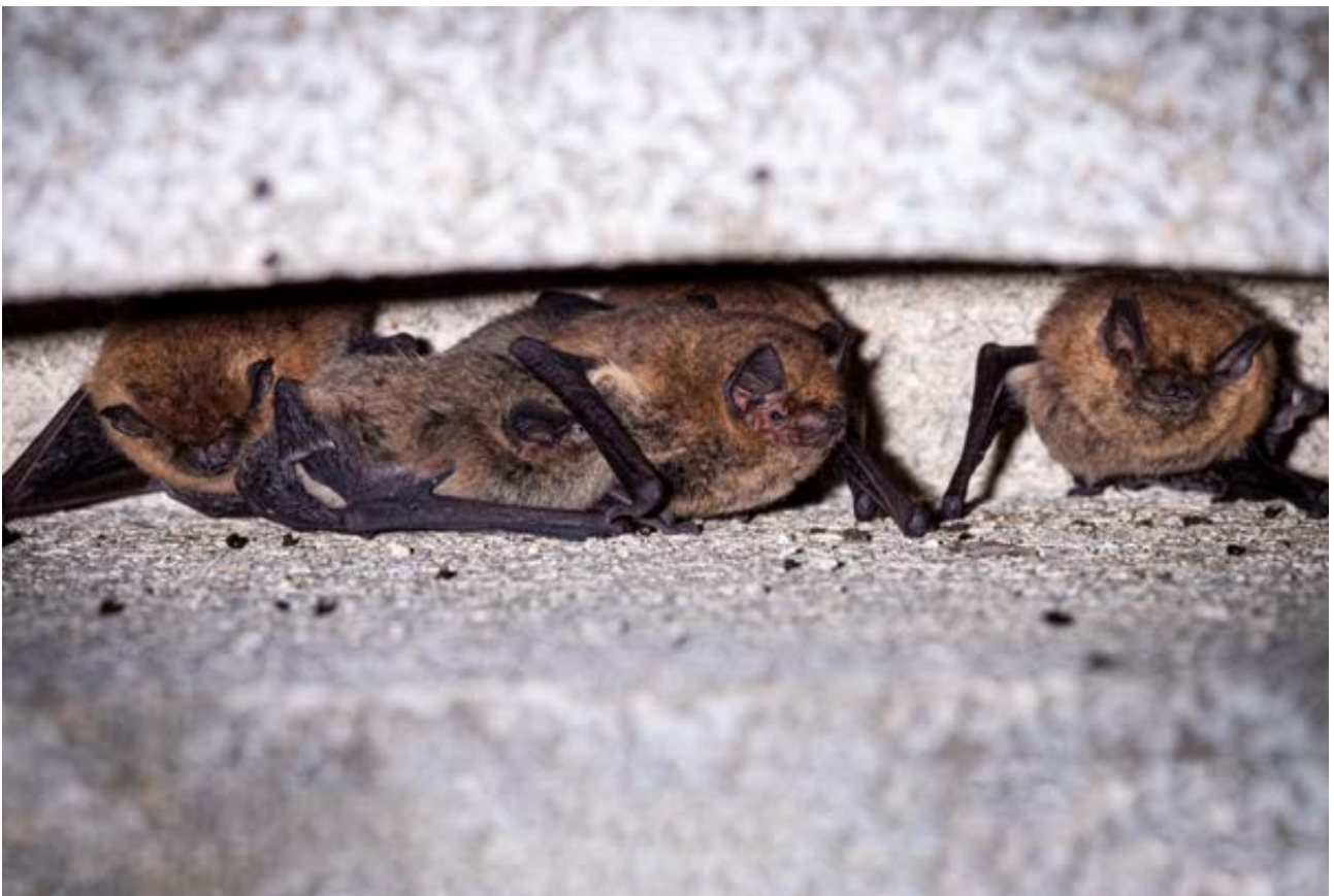
Wochenstube von Zwergfledermäuse in einem Fassadenkasten
