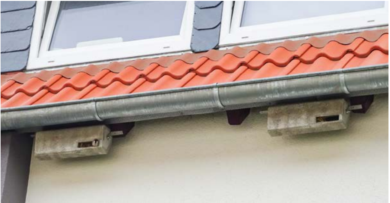
Ein im Handel zu beziehender Nistkasten mit jeweils einer Brutkammer für Mauersegler. Diese Kästen sind unterhalb der Dachrinne an den Dachsparren befestigt.
